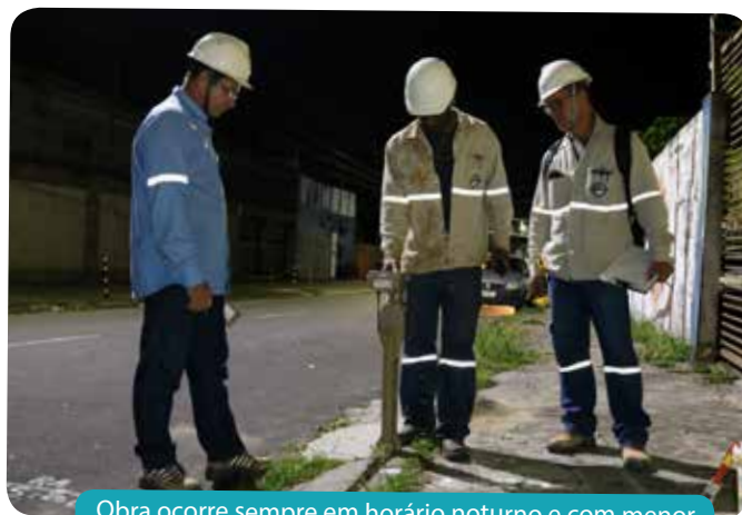
Obra ocorre sempre em horário noturno e com menor impacto às vias
