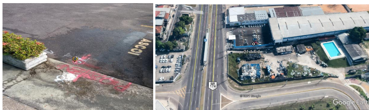
Foto 11 – Falha de Revestimento Estacionamento Cigas
