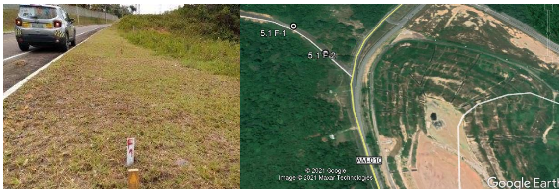
Foto 19 – Falha de Revestimento Manauara - Derivação NEOTEC
