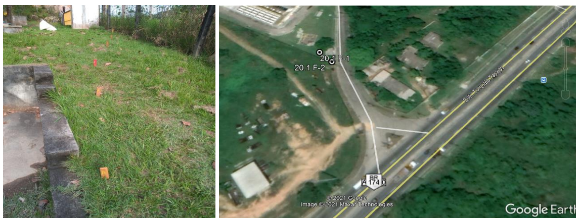
Foto 13 – Falha de Revestimento Dentro UTE Jaraqui
