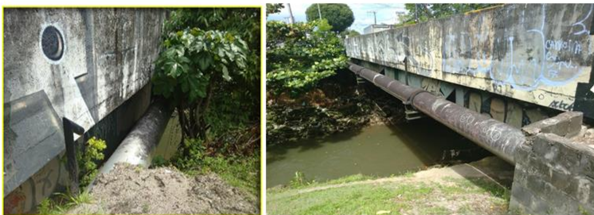
Foto 1 – Trecho de Inspeção Ponte Teomário Pinto
