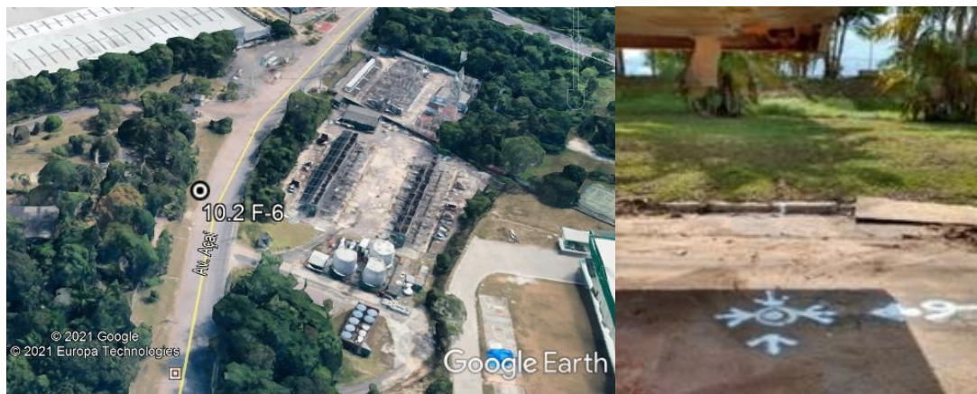
Foto 18 – Falha de Revestimento Av. Açai BIC
