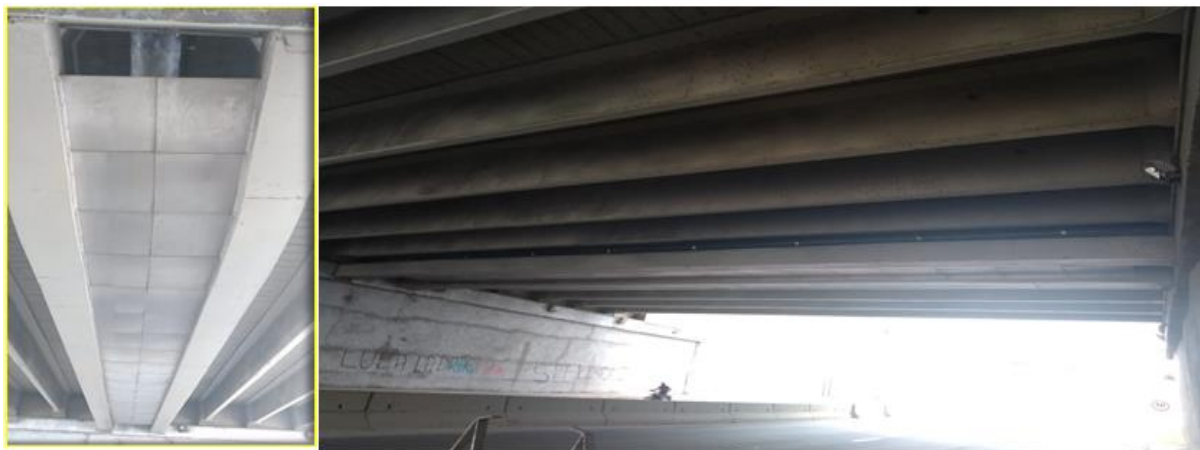
Foto 4 – Trecho de Inspeção Complexo viário 28 de março, Av. Torquato Tapajós
